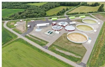
発酵槽や消化液貯留槽を備える (バイオガスプラント)
