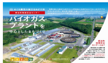
中鹿追環境保全センター施設
